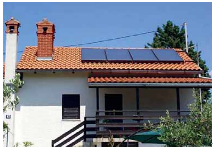
Slika 4. Primjer korištenja Sunčeve energije: sunčani toplinski kolektori
