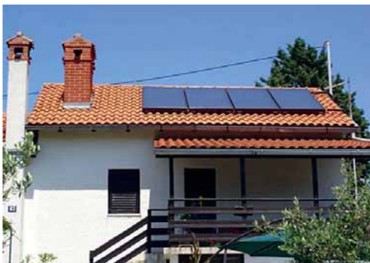
Slika 4. Primjer korištenja Sunčeve energije: sunčani toplinski kolektori
