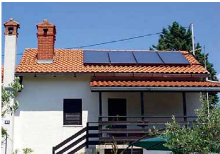
Slika 4. Primjer korištenja Sunčeve energije: sunčani toplinski kolektori
