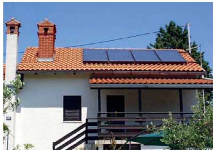
Slika 4. Primjer korištenja Sunčeve energije: sunčani toplinski kolektori
