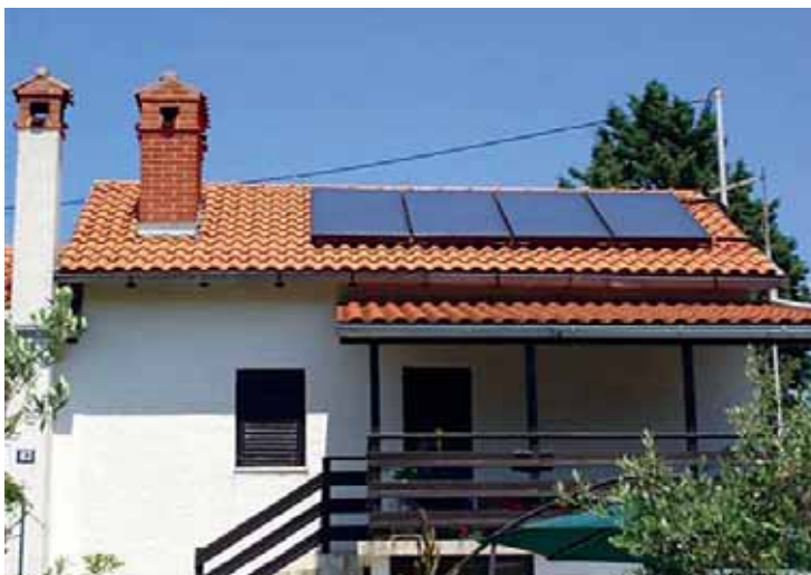
Slika 4. Primjer korištenja Sunčeve energije: sunčani toplinski kolektori
