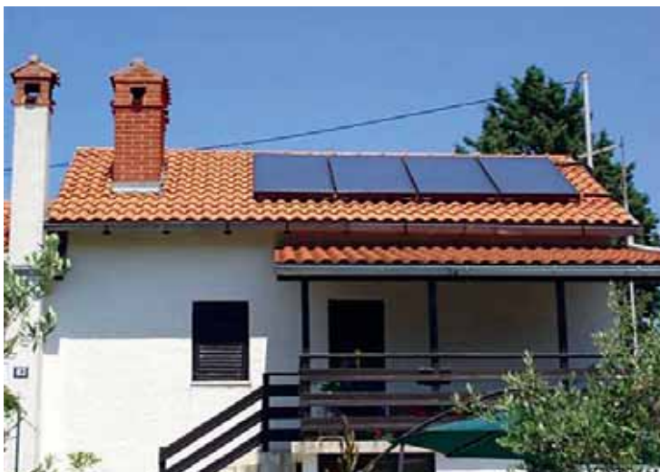
Slika 4. Primjer korištenja Sunčeve energije: sunčani toplinski kolektori
